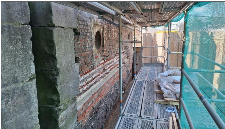
De restauratie werkzaamheden
