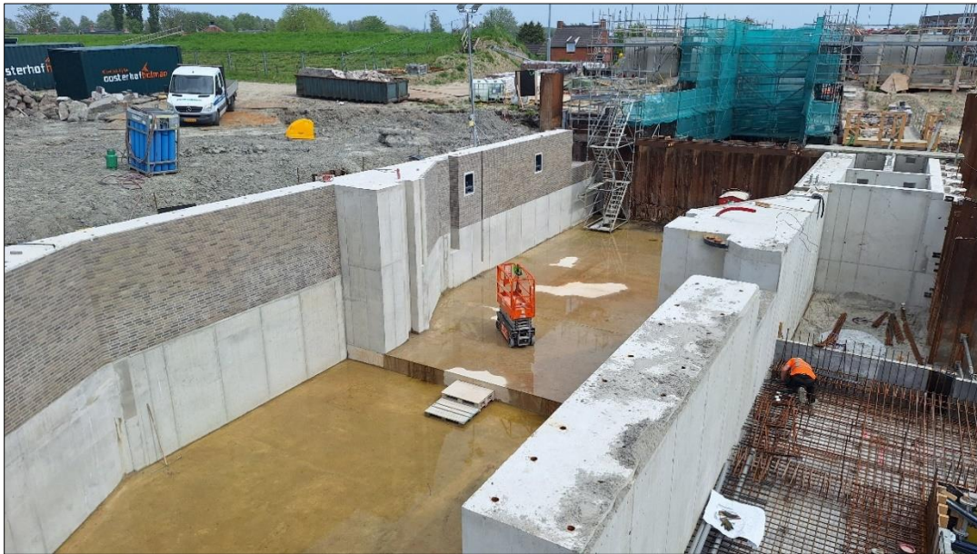
De nieuwe sluis
